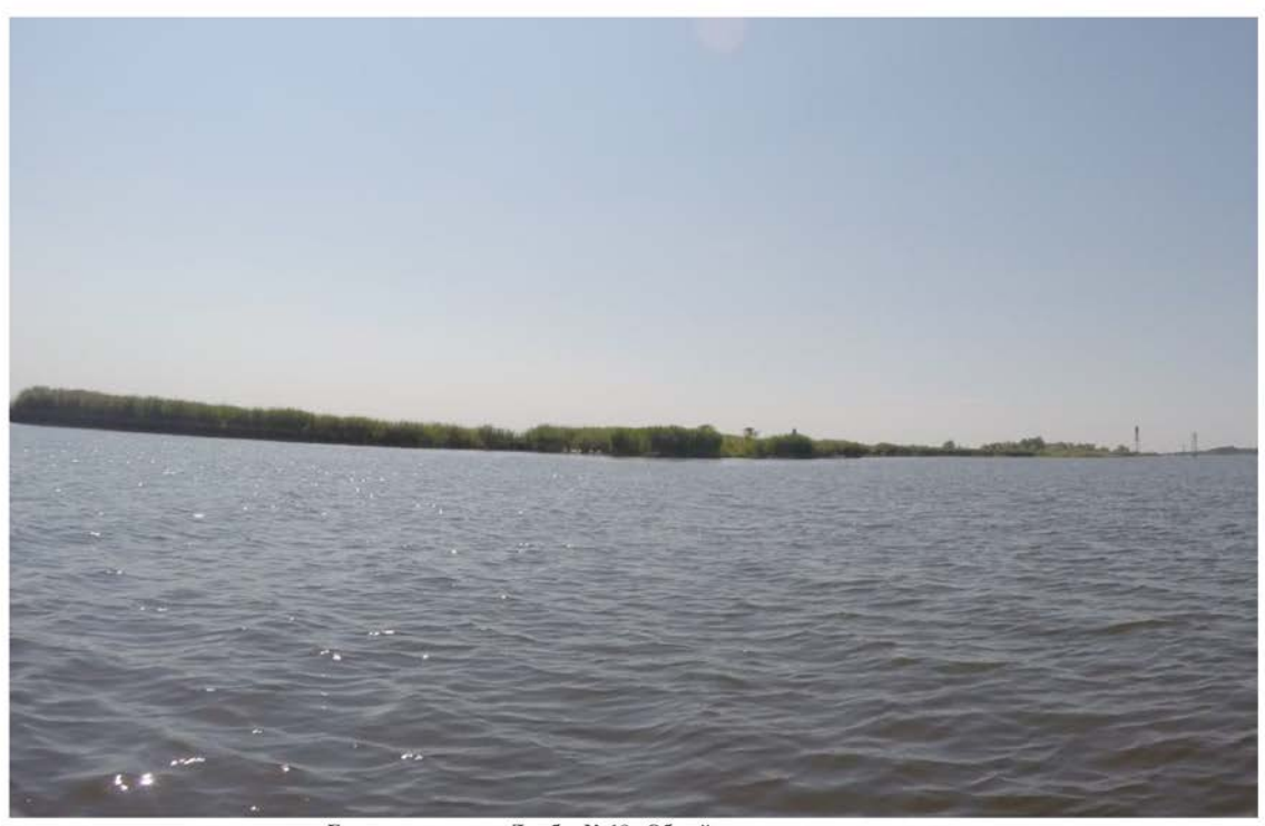
Берегоукрепление Дамбы № 10 . Общий вид со стороны канала.
