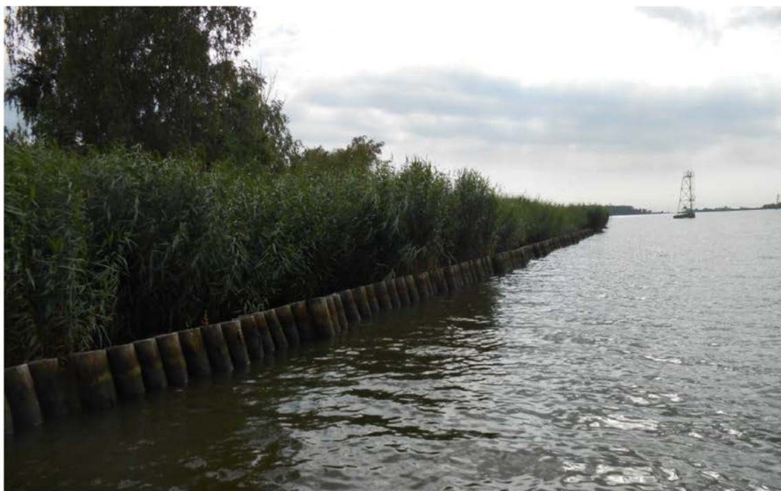
Берегоукрепление Дамбы № 10 (район ПК 311 – 312). Вид со стороны канала.
