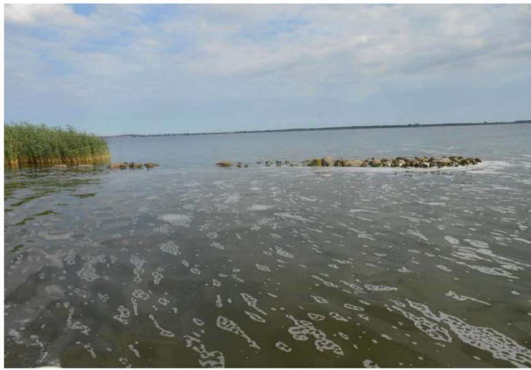
Берегоукрепление Дамбы № 10. Западная штора. Общий вид со стороны канала.
