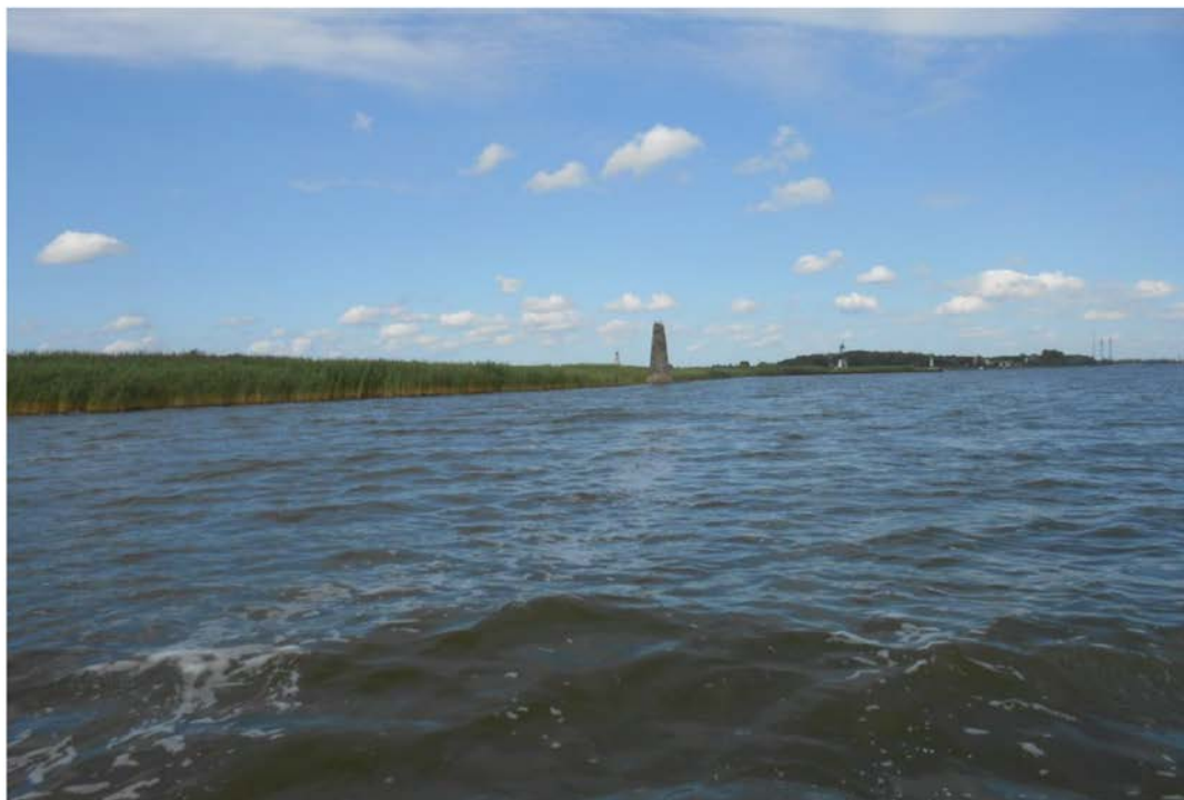
Берегоукрепление Дамбы № 10 . Общий вид со стороны залива.
