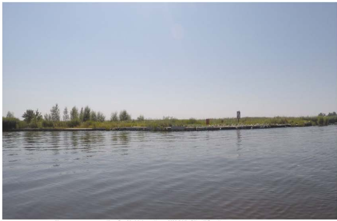
Берегоукрепление Дамбы № 10 (в районе ПК 318+50) . Общий вид со стороны канала.
