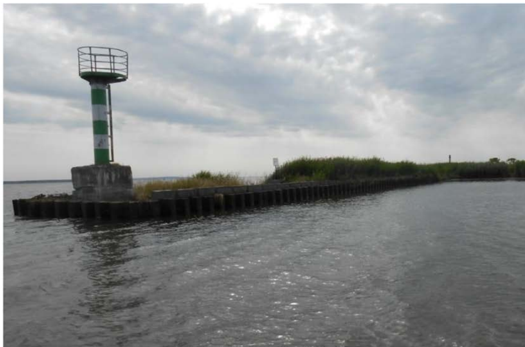
Берегоукрепление Дамбы № 10. Восточная штора. Общий вид со стороны канала.
