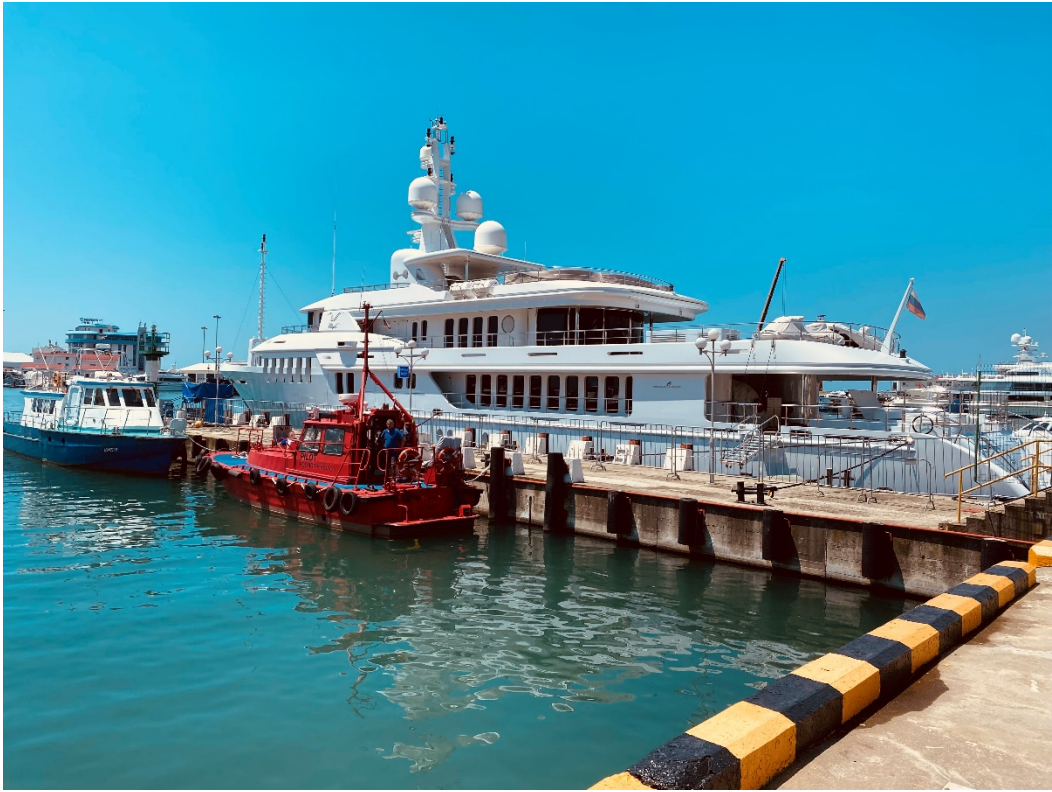
Рис. 3.4.2 Расположение отбойных устройств с южной стороны пассажирского причала № 5А
