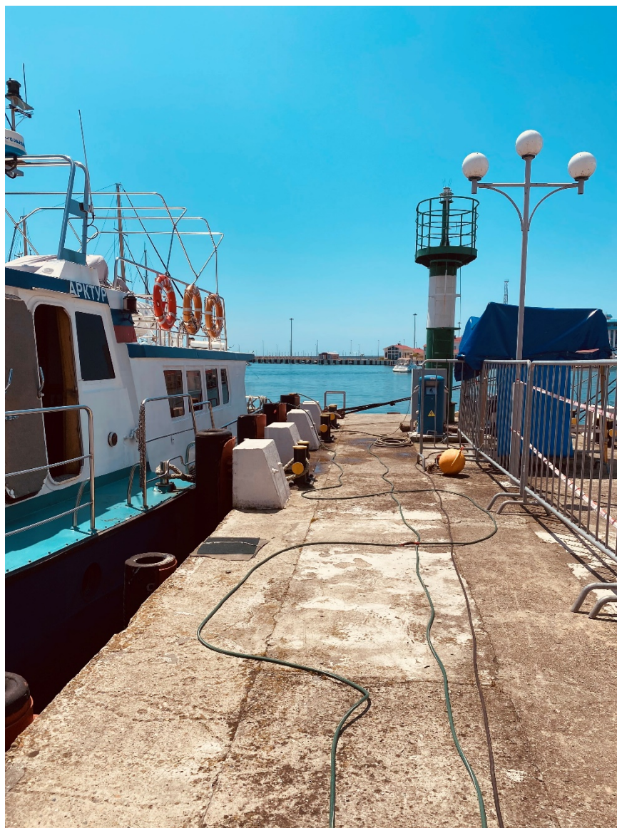
Рис. 3 Вид на «голову» пассажирского причала № 5А
