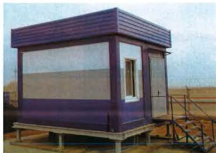
Рисунок 4 – Здание для размещения очистной установки серии «МОЙДОДЫР-Л(Н)»
